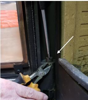
Enlevez la goupille et serrez la vis (dans le sens de l'aiguille d'une montre) en fonction de la vitesse de fermeture souhaitée. Remettez la goupille.
